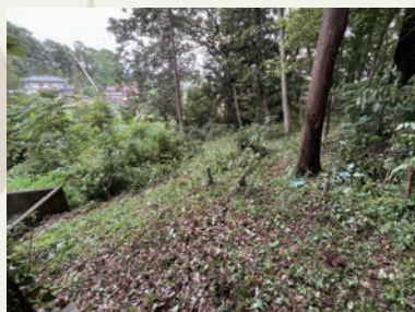
▲未着手だったエリアの作業後
