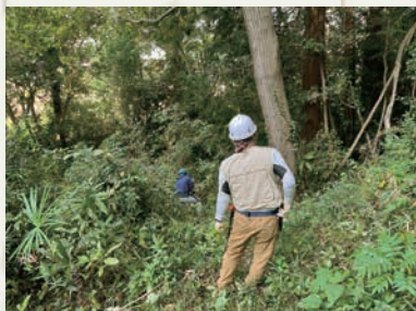
▲境界杭確認作業の様子
