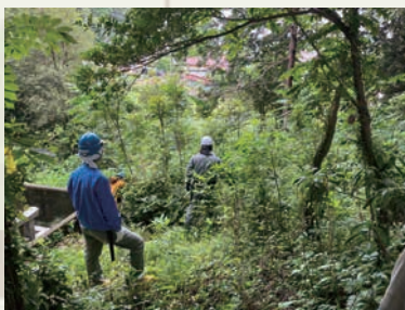
▲未着手だったエリアの作業前
